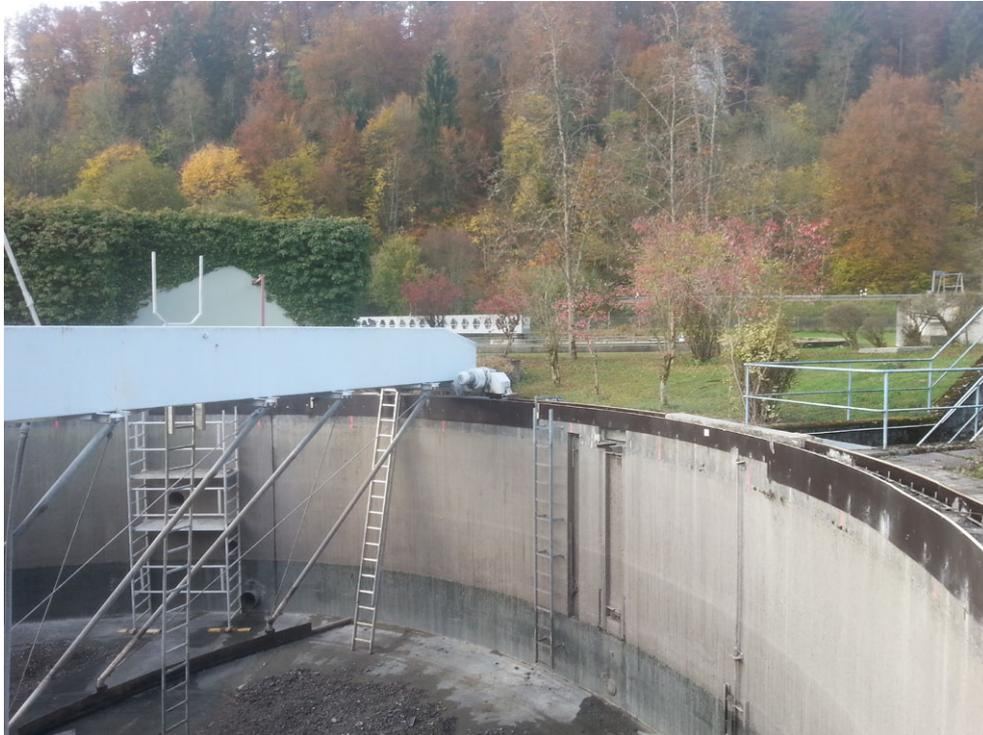
Einen absolut spannungsfrei austrocknenden Betonersatzmörtel einzusetzen war auch aufgrund der kreisrunden Form des Bauteils erforderlich.
