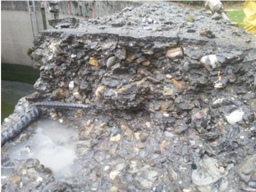
Der Altbeton war bis zur oberen Bewehrungsalge brüchig und musste bis zu 20 cm tief komplett entfernt werden.
