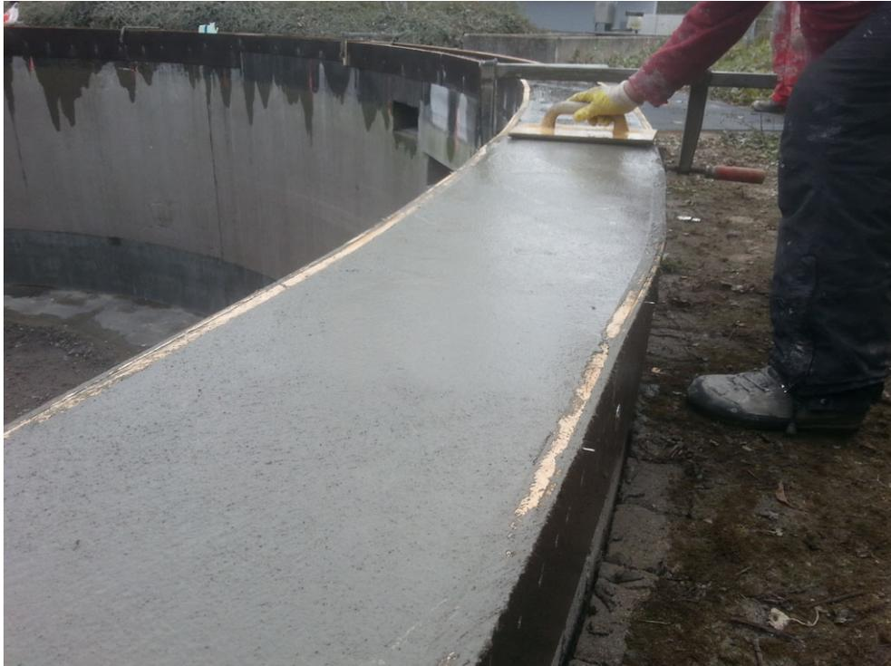
Der selbstverdichtende Betonerersatzmörtel PCI Nanocret R4 Fluid eignet sich ideal für eine enge Bewehrungshinterfüllung und statisch relevante Bauteile. Er ist kompakt und hinterlässt beim Glätten nur sehr wenige Poren.
