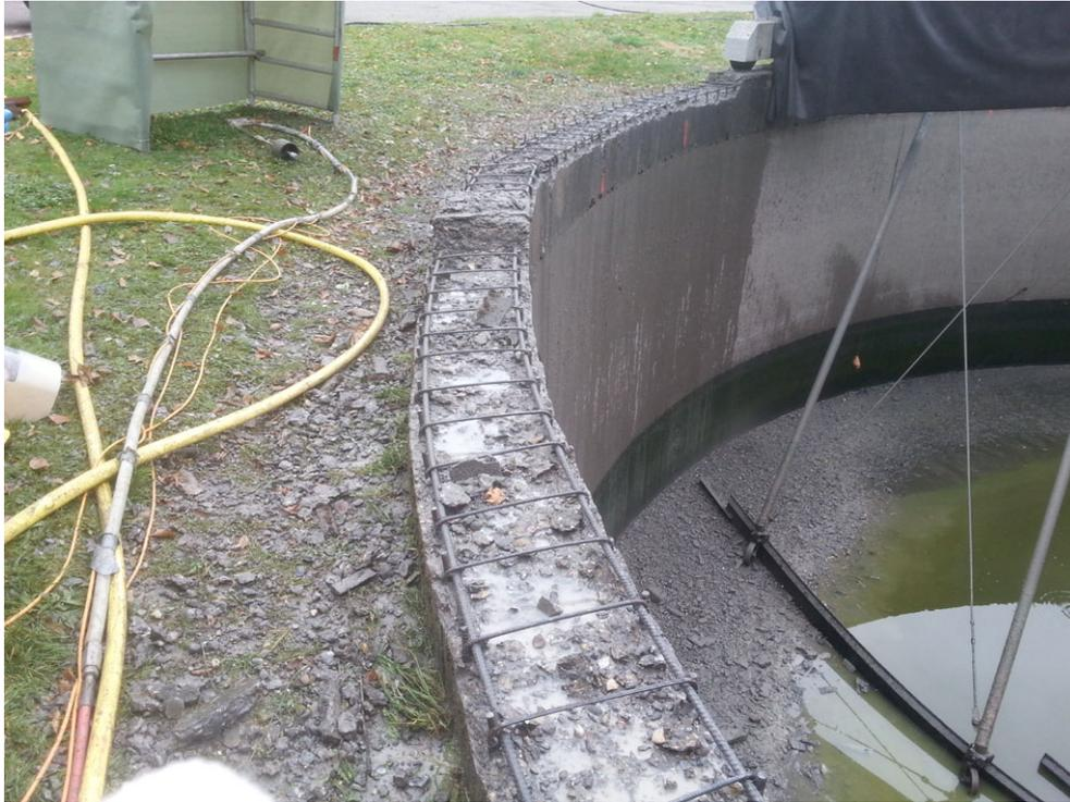
Sanierung der Räumlerlaufbahn in der Kläranlage Veringendorf: Mittels Höchstdruck-Wasserstrahlverfahren legte die beauftragte Beton-Sanierungs-Technik Waschek GmbH die obere, durch Enteisungssalze zerstörte Betonschicht bis unter die Bewehrungslage frei und reinigte sie.
