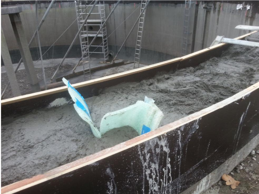
Der fließfähige Instandsetzungsmörtel PCI Nanocret R4 Fluid konnte in nur einem Arbeitsgang 20 cm stark eingebracht werden.
